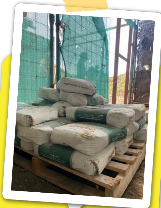
Sacos de cemento, morteros
